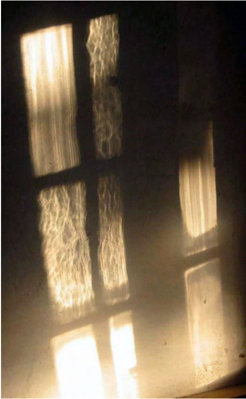
Fig.34. Ved udskiftning af ruder er typen af ruder-glas værd at overveje. Glastypen har betydning indefra, fordi typerne bryder lyset på hver sin måde. Vinduesglasset har også betydning for oplevelsen udefra, fordi glastyperne reflekterer omgivelserne forskelligt. Derfor giver det mening at bruge traditionelle typer vinduesglas. Nederst til venstre ses moderne float-glas uden struktur. De øvrige ruder er af cylinderglas (spættet struktur) og trukket glas (stribet struktur).
