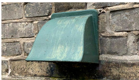
Fig.44. Østerhus' friskluftventiler må ikke fjernes eller ændres.
