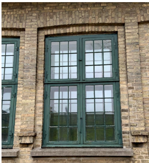
Fig.33. Bygningsdetaljer som døre og vinduer spiller en særlig rolle for helhedsindtrykket på Sankt Hans. Det skyldes dørenes fine profileringer og vinduernes elegante, lette udtryk. Det er vigtigt at bevare området korskpostvinduer med tynde stålsprosser. Ny termovinduer vil give et helt andet udtryk, fordi karme, rammer og sprosser skal være meget kraftigere. Her ses et eksempel på en dør og et vindue på bygning 21 af Kurhus. Kalfatring omkring vinduer bør foretages med hydraulisk mørtel uden cement. De steder, hvor der oprindeligt har været dækningsliste, bør kalfatringen afdækkes med liste malet vogngrøn.
