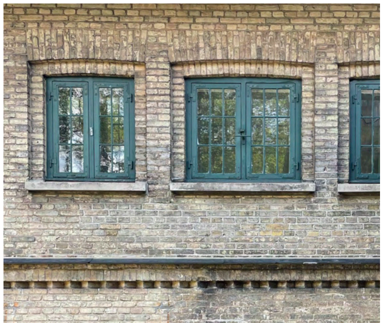
Fig.35. Et smukt facadeudsnit, hvor der er brugt traditionelle håndværksmetoder. Når de bevaringsværdige bygninger skal vedligeholdes og repareres, bør man bruge traditionelle materialer og håndværksmetoder, hvor det er muligt. Ved muråbninger bør der ikke anvendes skårne sten men sten med fulde kanter og formsten. Samlinger, sammenstød og reguleringer i murværket bør ske i fortanding med tilstødende murflader og ikke ved fugning. Når murværk blottes - f.eks. når et trådhegn afmonteres - bør skader på teglsten og fuger udbedres. Ved erstatning af fuger bør der anvendes hydrauliske fuger uden cement.
