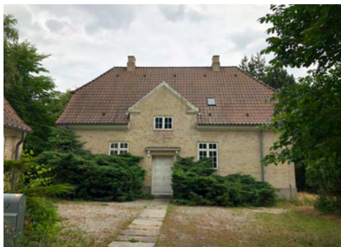
Fig.51. Den bevaringsværdige villa på Parcelgårdsvej 2. I modsætning til de andre bebyggelser med facader og gavle i gule teglsten har villaen tag i rød vingetegl og døre og vinduer, som er malet hvide. Desuden er sprosserne ikke i stål men i træ. På fotografiet ses det østvendte tag, hvor der må etableres to tagvinduer. Tagvinduerne skal overholde de overordnede bestemmelser, for så vidt angår den symmetriske placering. I venstre side af fotografiet anes en sekundær bebyggelse, som skal bevares, fordi den er opført i samme byggestil som villaen.
