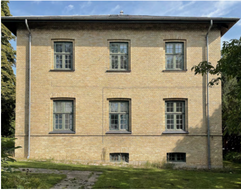
Fig.48. Facade mod vest på Vesterhus.
